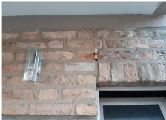
Figuur 3.11: Aan deze gevel is (links op de foto) een plastic exclusion flap over een open stootvoeg geplaatst. Vleermuizen kunnen daardoor wel uit de voeg, maar niet erin. Rechts op de foto zijn houten wigjes in een open stootvoeg geplaatst, zodat vleermuizen niet meer door de voeg kunnen (bron: Peter Twisk).
