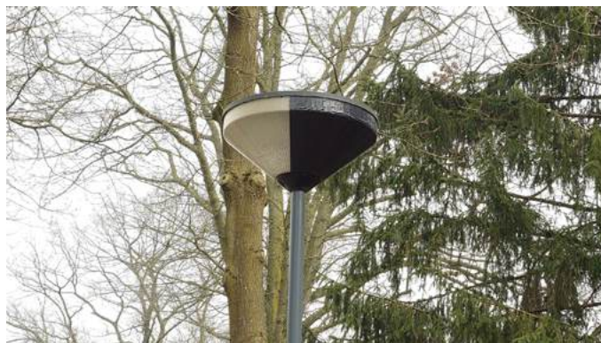
Figuur 3.13: Voorbeeld van een aangepast armatuur: afgeschermd naar boven en naar achteren (bron: Erik Korsten, Zoogdierverseniging).
